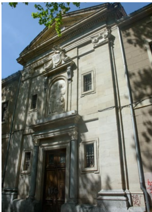
Portada del nuevo convento, situado en la calle Vicente Goikoetxea de Vitoria que acogió a las Carmelitas Descalzas de Vitoria hasta que pasó a manos de las Brígidas hace más de un siglo. Foto: José Antonio Abasolo.
