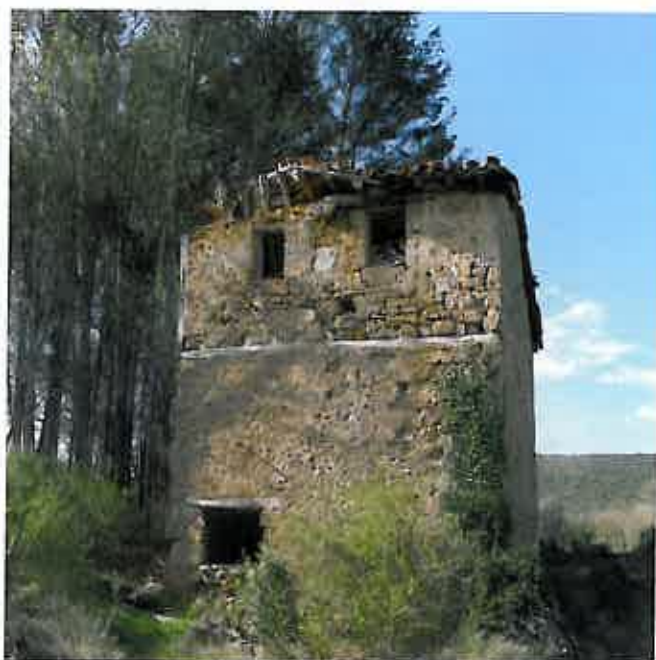
Salinas Edificio pozo de sal
