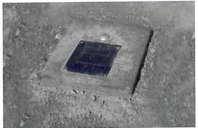
La visita de la última etapa finaliza en el mojón 472 pero para enlazar con la siguiente etapa, se llega hasta el número 1 de la etapa 1-14 M entre Subijana de Álava/Subillana Gasteiz y Mendoza, que da inicio de nuevo a las 13 etapas. Allí, al construirse el Polígono Industrial de Subillabide, el mojón de piedra fue sustituido por una placa metálica grabada. Foto tomada durante la visita de mojones del 15 de septiembre de 2015. Foto: Tomás del Río.
