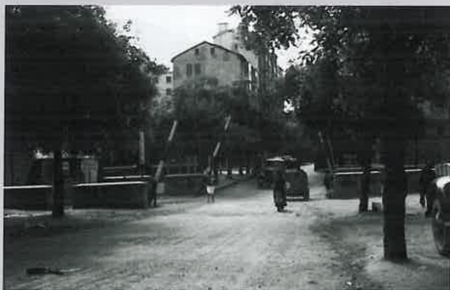
Paso a nivel del antiguo Vasco-Navarro.
