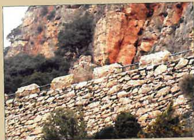
▲ Detalle de calzada
