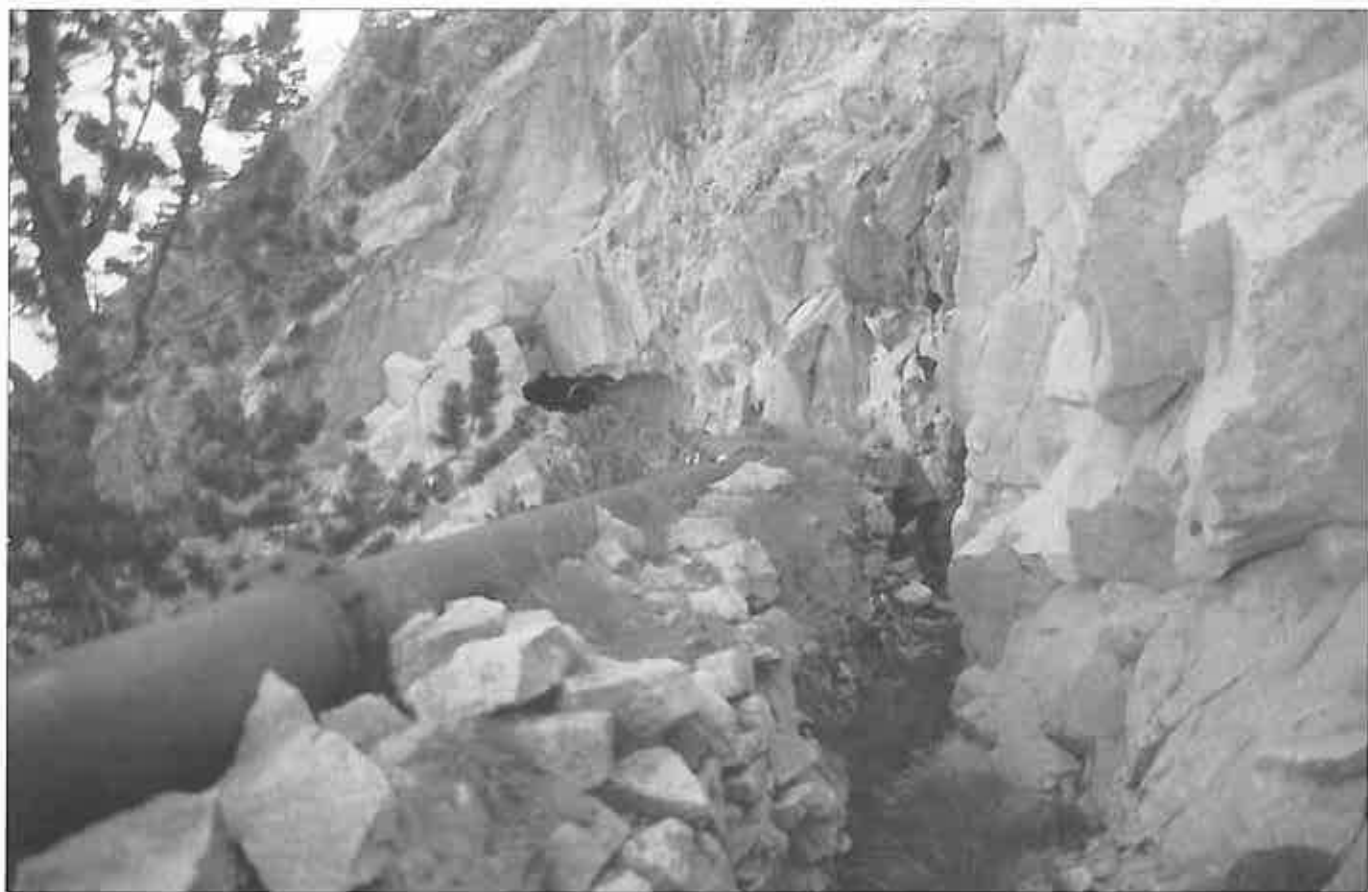
A las puertas del primer túnel, encajonados entre la pared y el trazado de la tubería
