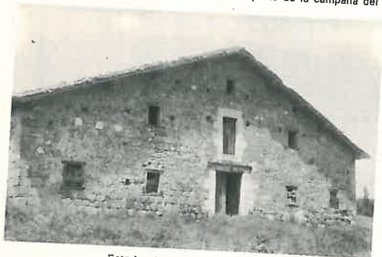
Estado del Edificio en 1972
